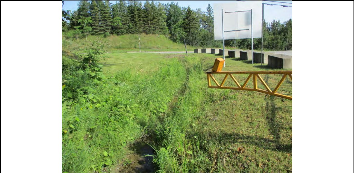
IMG_2754.JPG Image 30: L'eau en direction du fossé de route du boulevard Saint-Germain.
