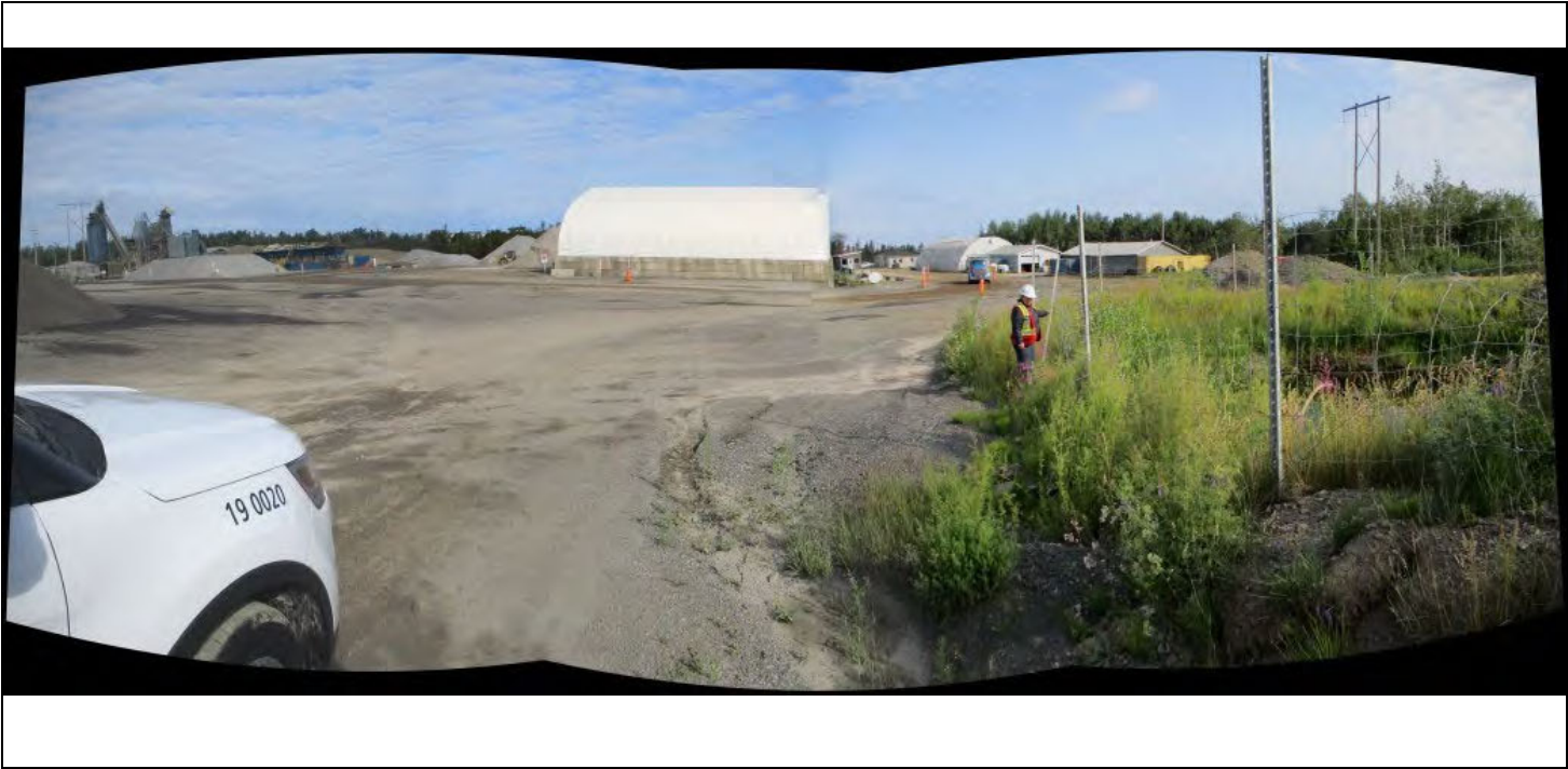
Fusion IMG_2714-2715-2716.jpg Image 9: Vue de l'emplacement de cette accumulation par rapport à l'usine.
