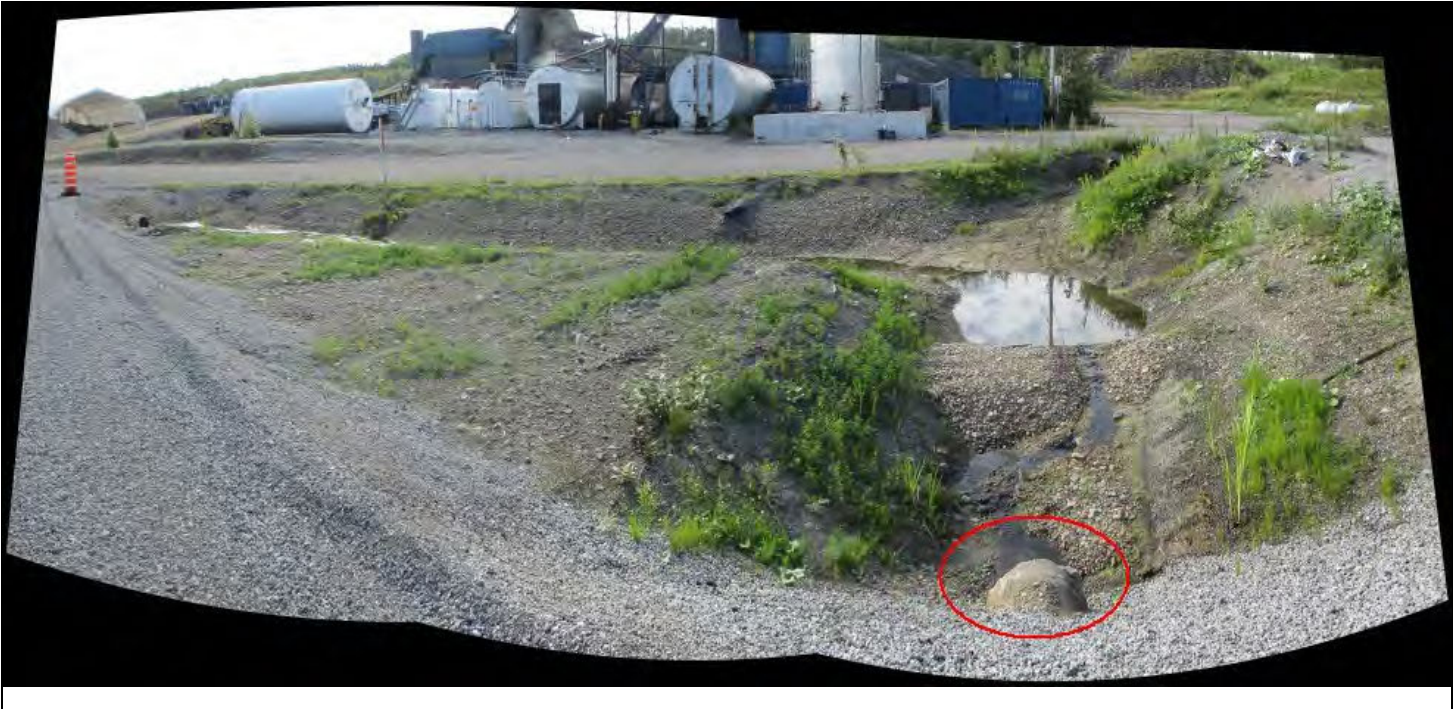
Fusion IMG_2742-2743-2744-2745.jpg Image 23: L'eau canalisée du terrain se rejoint vers le tuyau bétonné désigné par l'ellipse rouge.
