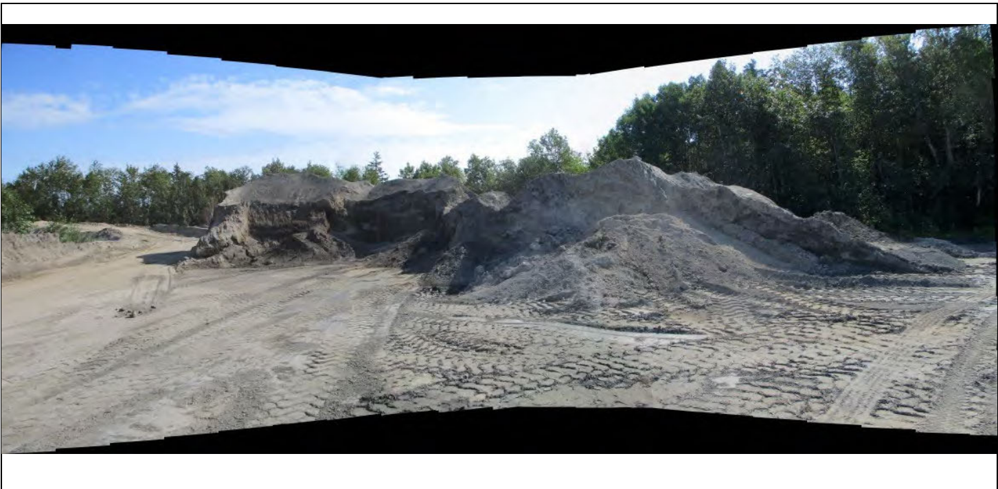
Fusion IMG_2761-2762-2763-2764.jpg Image 32: Vue d'accumulation de poussière d'asphalte sur le terrain de l'usine.
