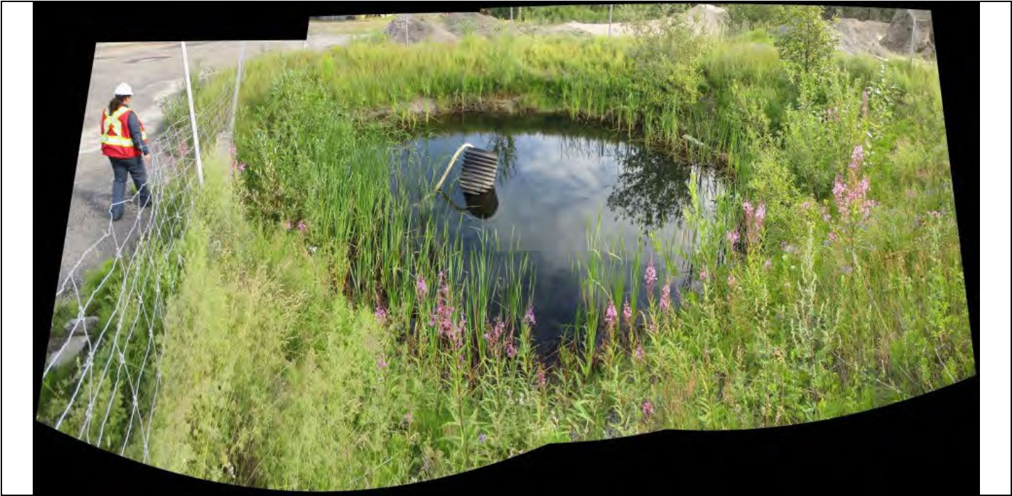
Fusion IMG_2711-2712-2713.jpg Image 8: Vue d'une accumulation d'eau sur le terrain de l'entreprise.
