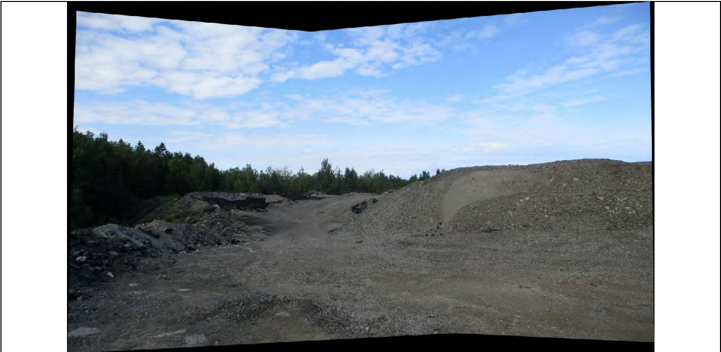
Fusion IMG_2724-2725.jpg Image 13: Vue à partir du dessus du tas de résidus de béton bitumineux.
